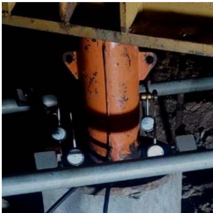
Figura 10 - Extensômetros da estaca teste.
