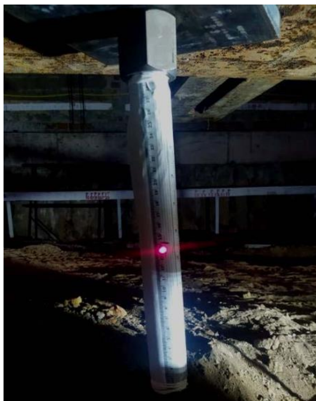
Figura 11 - Sistema de Acompanhamento dos deslocamentos.
