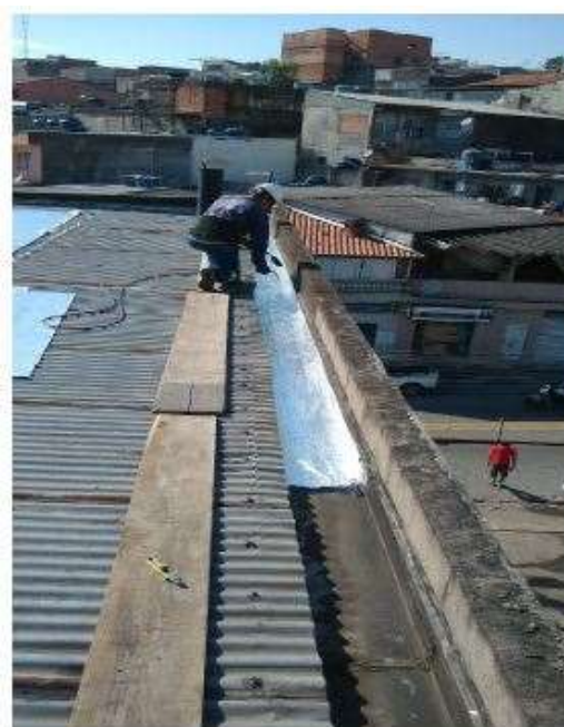
Figura 18 – Impermeabilização de calha com manta.
