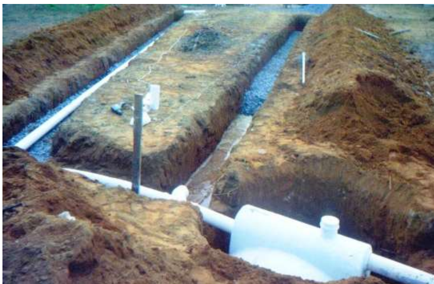
Figura 10 – Valas de infiltração sendo construídas.
