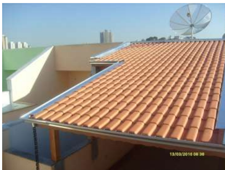
Figura 20 – Calha de alumínio.
