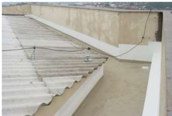
Figura 17 – Calha de concreto.
