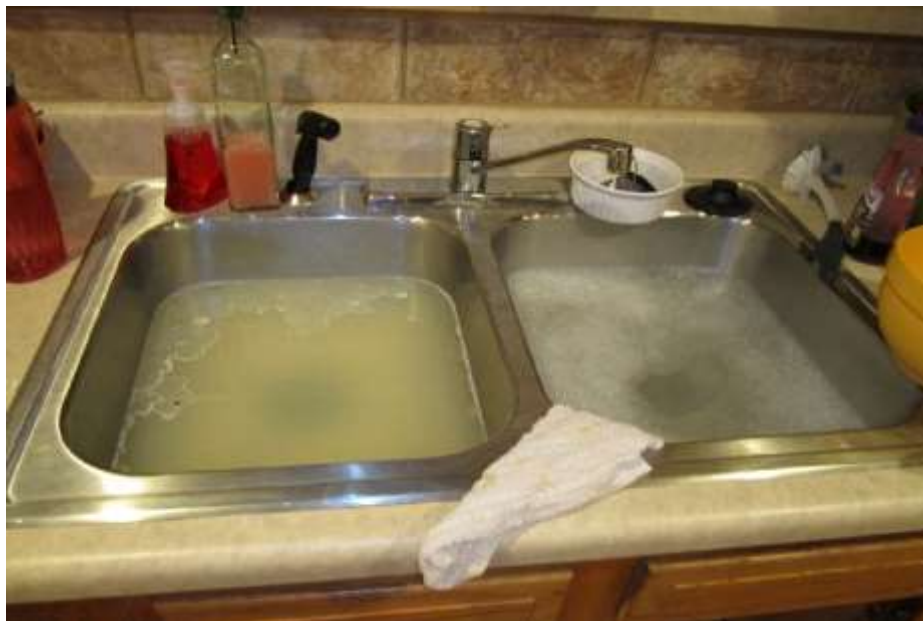
Figura 28 – Entupimento de pia de cozinha.
