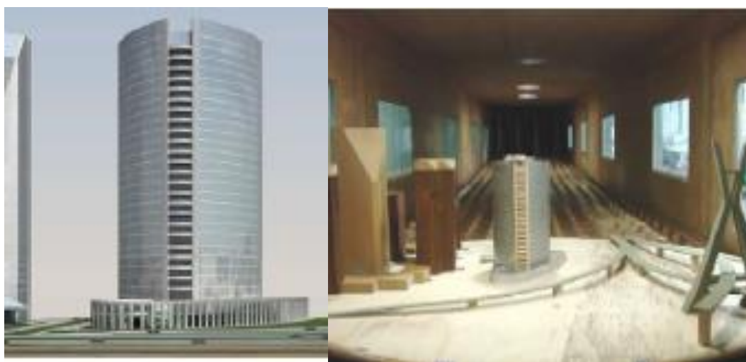
Fig. 5.19 Edifício CENU – Torre IV a) Maquete arquitetônica e b) Modelo reduzido para ensaio em Túnel de Vento Fonte: Loredo-Souza (2007) em Siqueira (2009; p.44)
