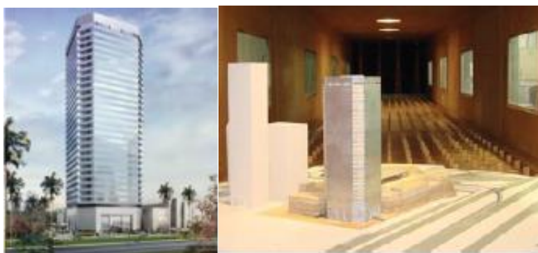
Fig. 5.1 Edifícios Odebrecht Atlanta
