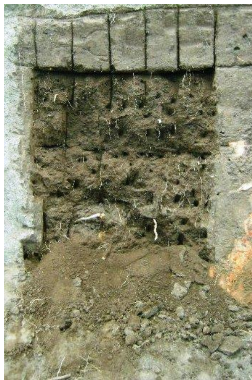
Detalhe da retirada de torrões
