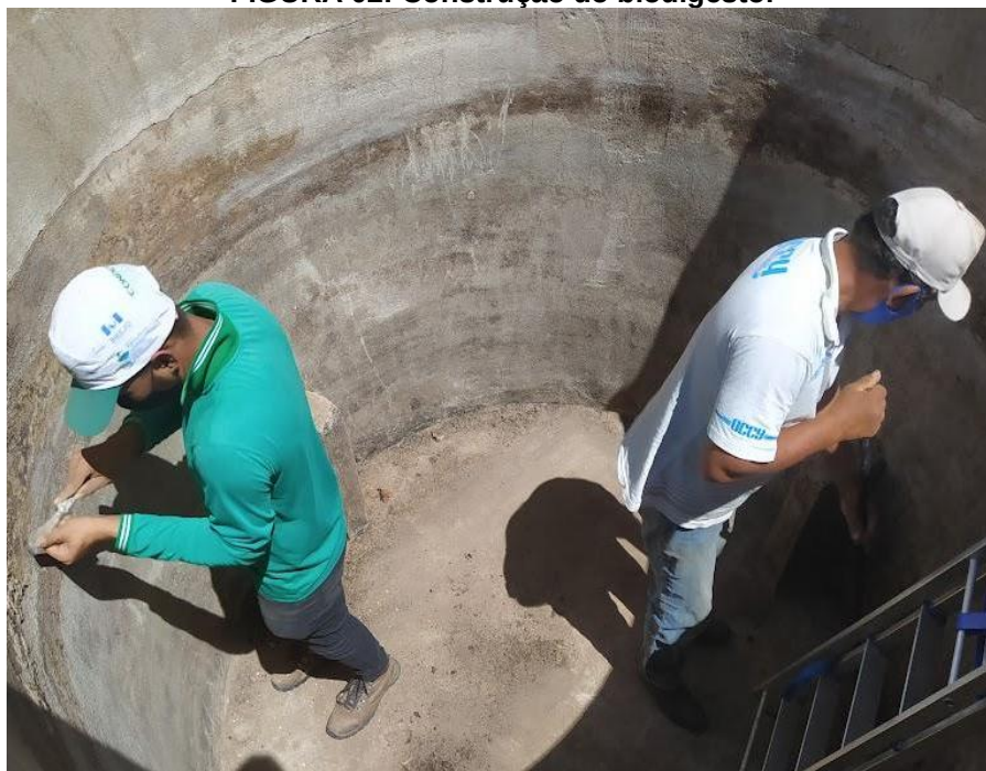
FIGURA 02: Construção do biodigestor
