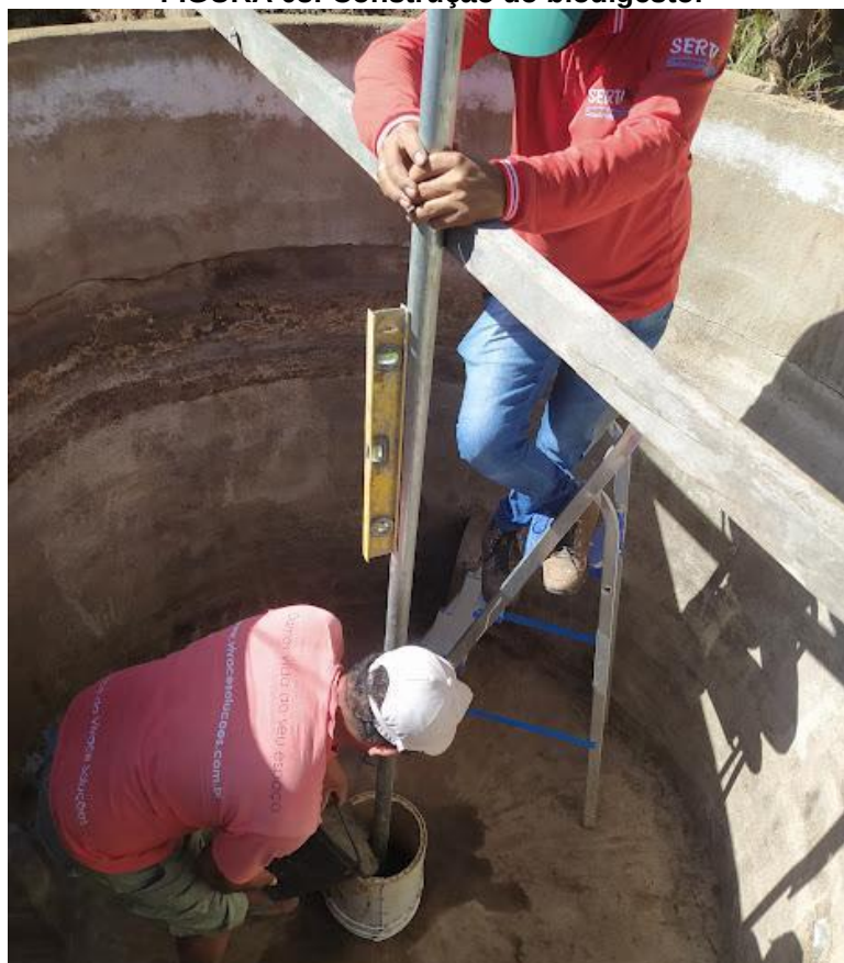
FIGURA 03: Construção do biodigestor
