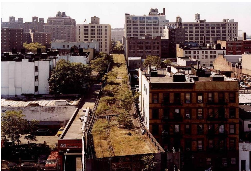
Imagem 1 - A linha férrea elevada que viria ser o High Line
