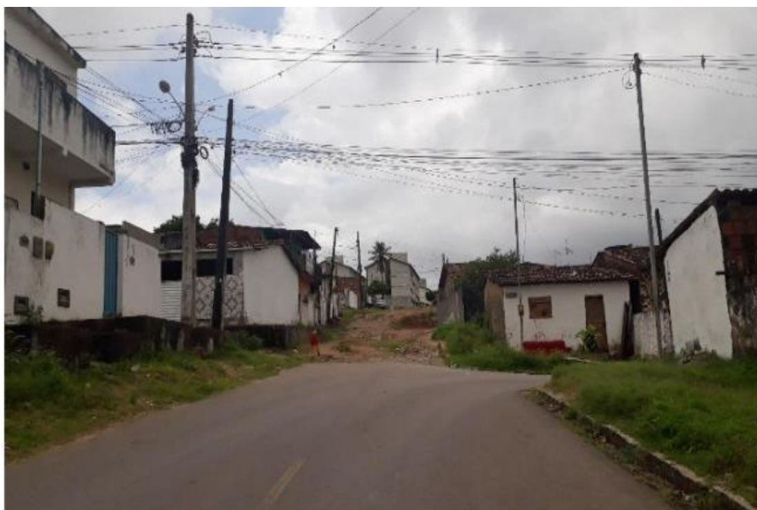
FIGURA 9 - Ruas sem pavimentação
