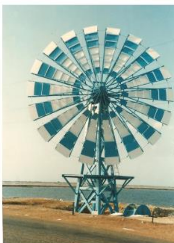
Figura 7 - Rotor multipás. (Fonte: Rodrigues, 2011)
