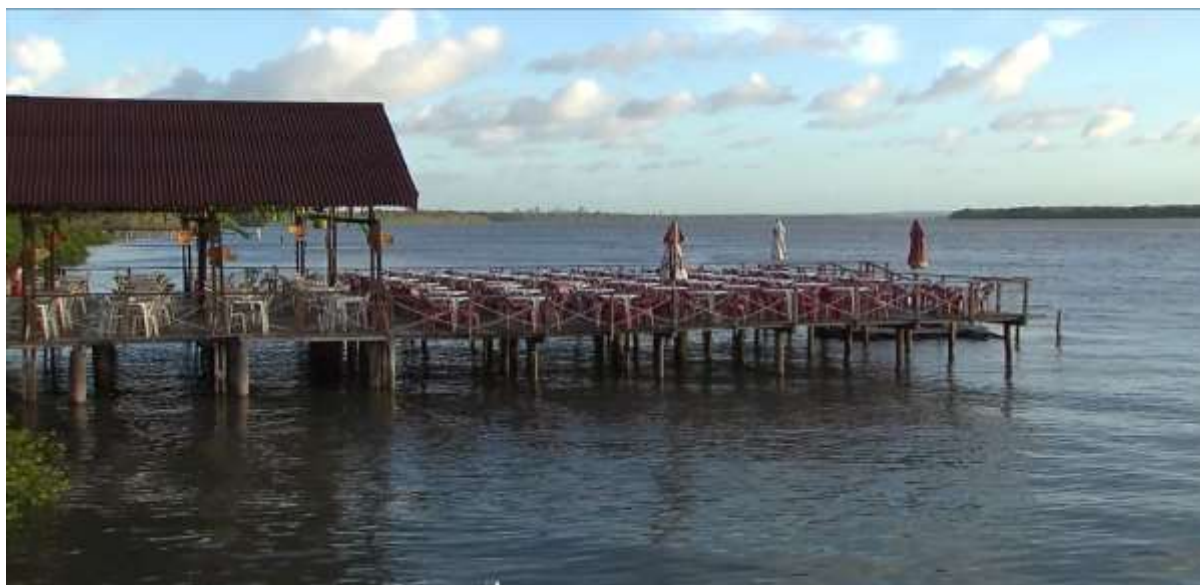
Figura 30: Plataforma sustentada por estacas de madeira fincadas no leito do rio Paraíba
