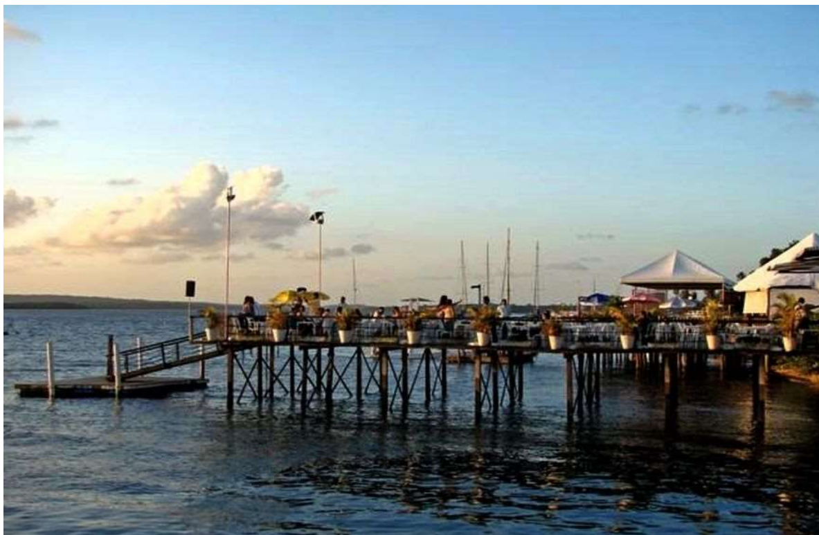
Figura 26: Plataforma de um dos restaurantes que avança sobre o rio Paraíba na Paraíba do Jacaré
