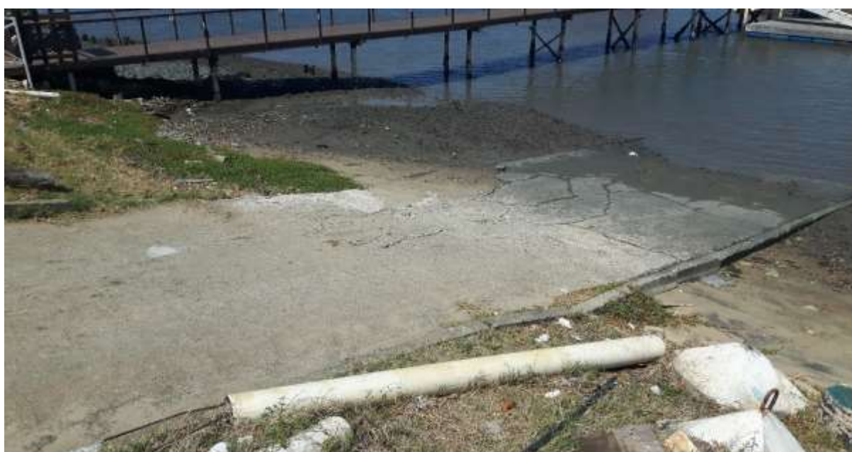
Figura 10: Rampa de concreto construída nas margens do rio Paraíba
