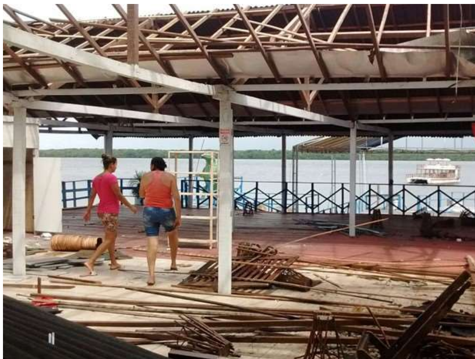
Figura 35: Comerciantes realizando a retirada de parte da estrutura de seus antigos empreendimentos
