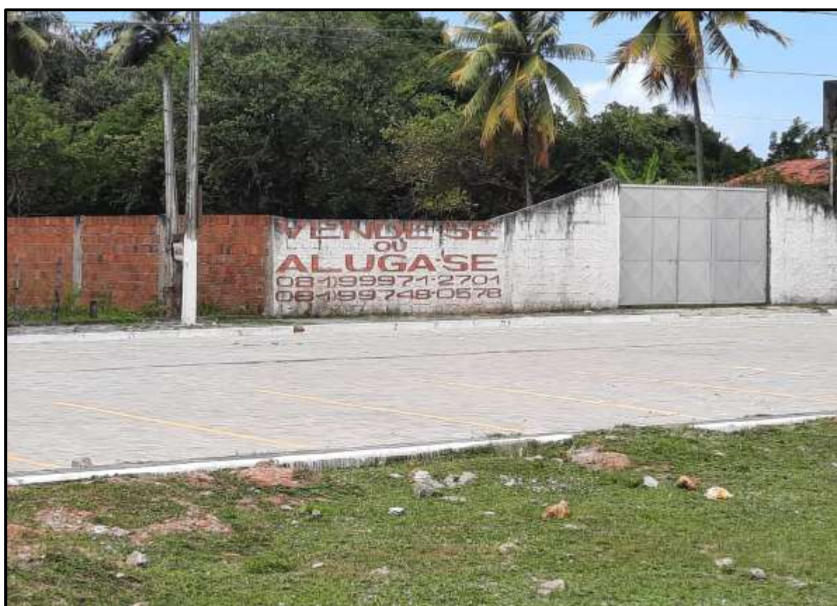
Figura 46: Lote “A” da área desmembrada, com estacionamento do Parque Turístico Jacaré a frente
