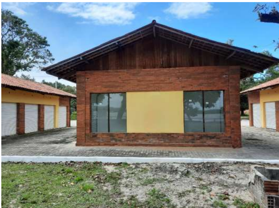
Figura 42: Visão frontal do novo Centro de Comercialização de Produtos Artesanais no Parque Municipal Turístico de Jacaré
