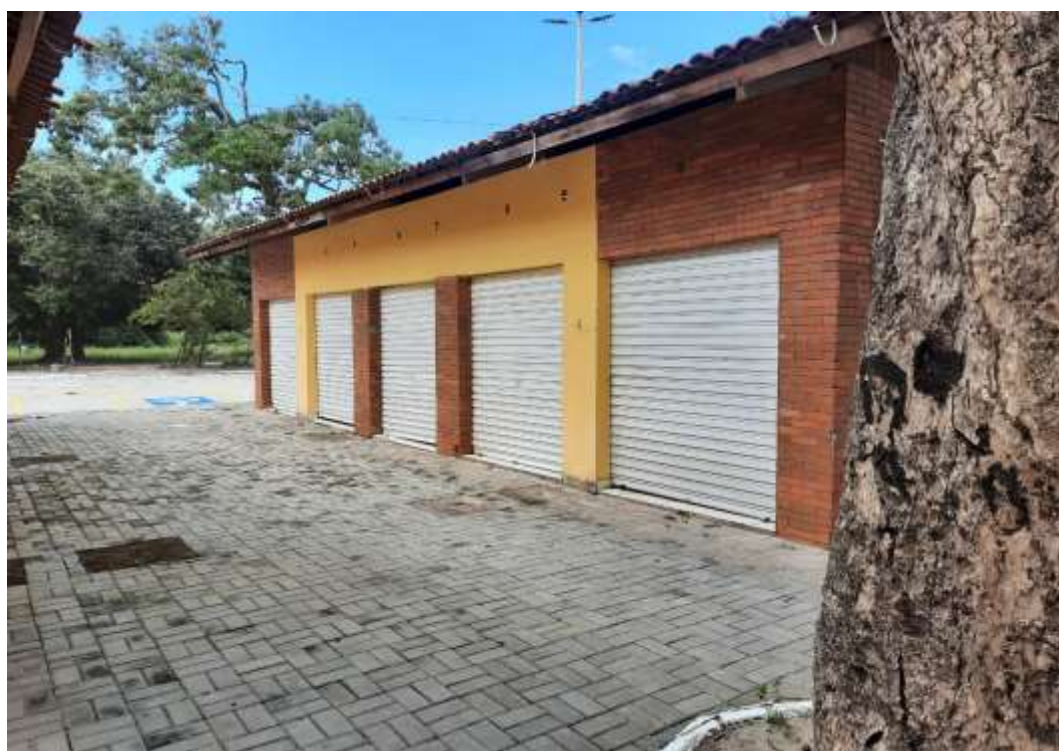
Figura 43: Visão lateral dos boxes do novo Centro de Comercialização de Produtos Artesanais no Parque Municipal Turístico de Jacaré
