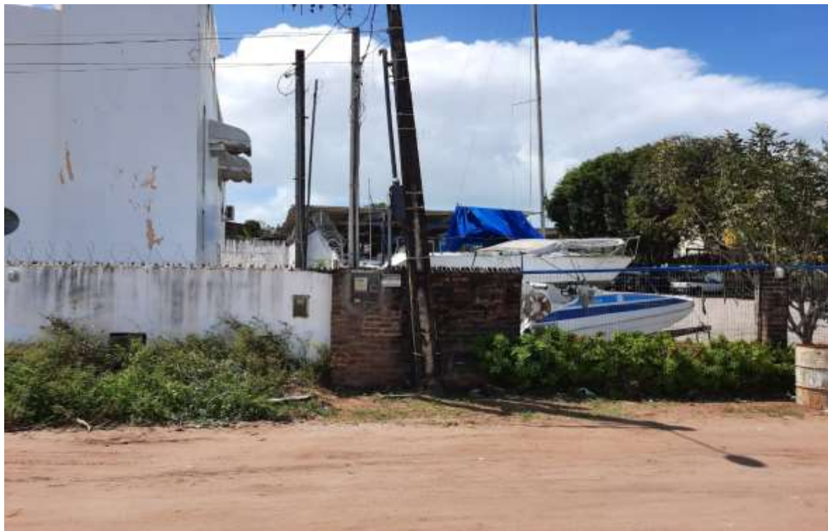
Figura 64: Muro que separa um dos centros náuticos dos fundos dos lotes onde estão construídas as residências da Vila SOAJE
