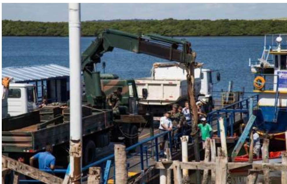
Figura 34: Equipamentos do Exército retirando estacas de madeira instaladas no leito do rio Paraíba
