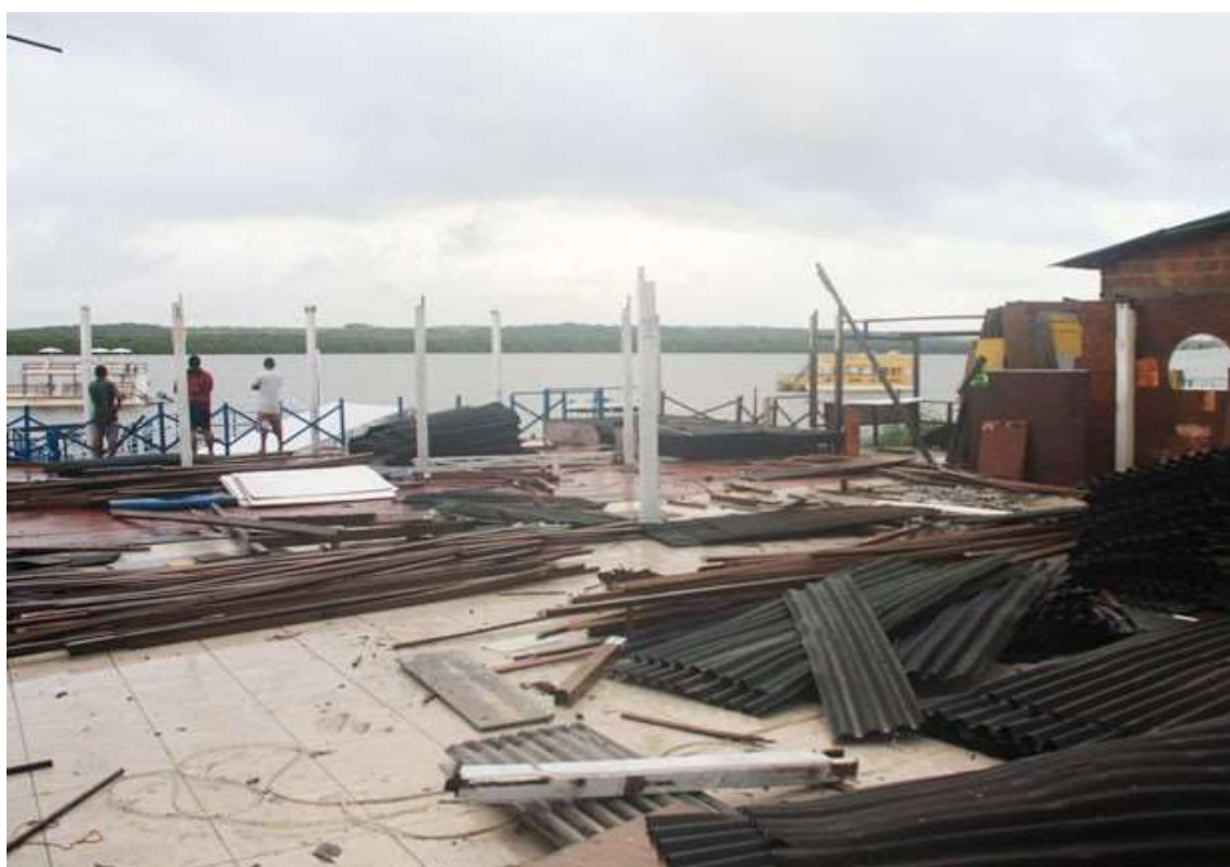
Figura 32: Restos da estrutura de um dos restaurantes, com materiais destinados ao reaproveitamento
