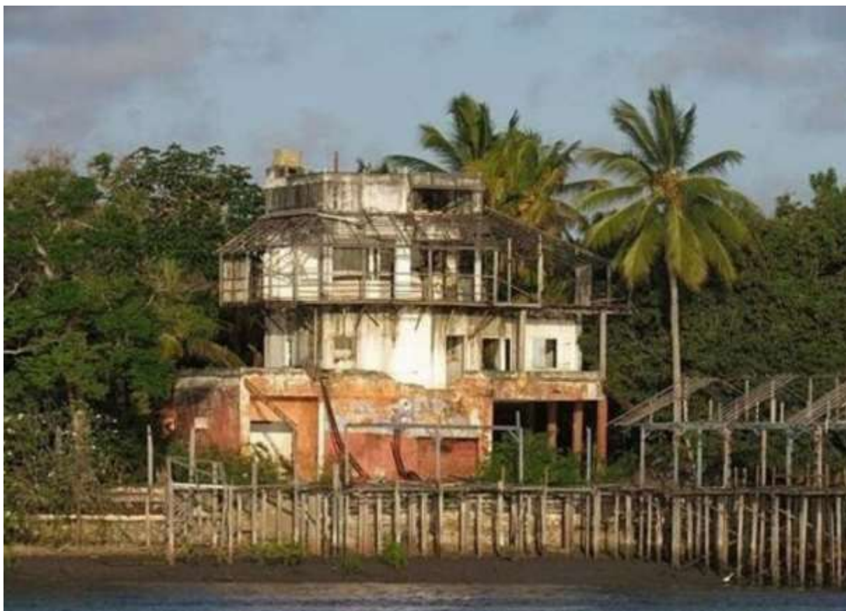
Figura 17: Estrutura do Jacaré Bar após o encerramento das suas atividades
