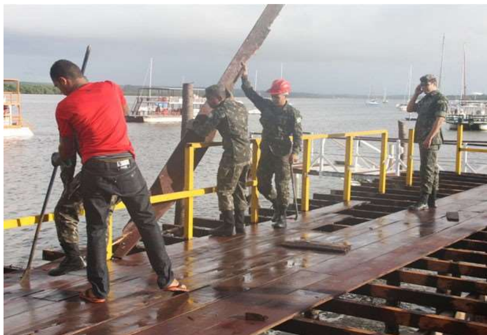
Figura 33: Exército realizando a derrubada das últimas estruturas dos antigos restaurantes
