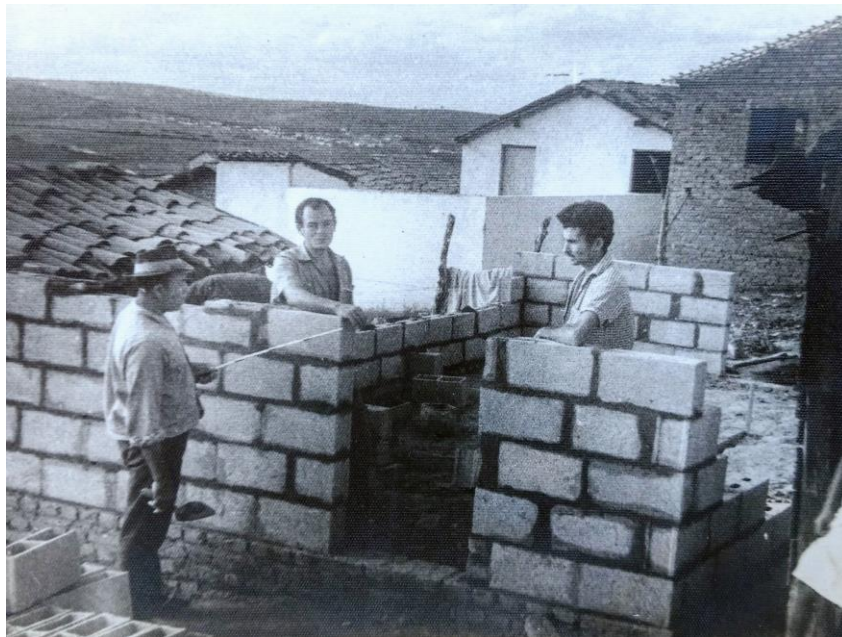
Figura 2 - Populares construindo suas casas com tijolos desenvolvidos pelo Irmão Urbano nos anos de 1970
