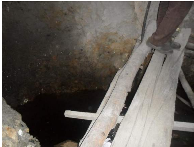
Figura 41: Detalhe nas condições de insegurança do trabalho. Apenas uma tábua de madeira, rachada em algumas partes, impede que o garimpeiro caia na profundidade da galeria.
