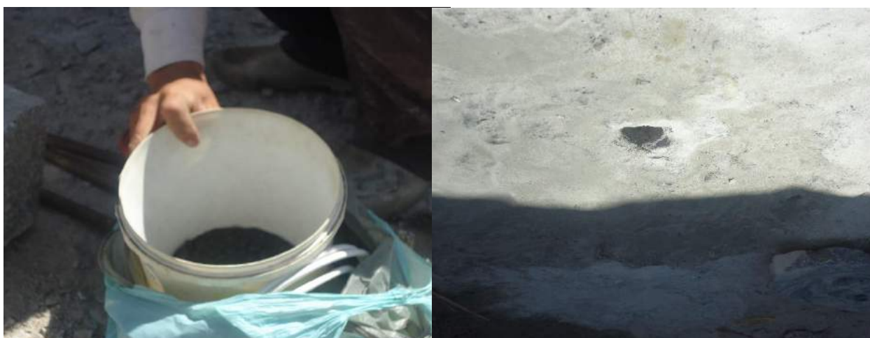
Figura 46 – Explosivos e Furo Preparado para Receber Explosivos em Lavra em Picuí, 2012
