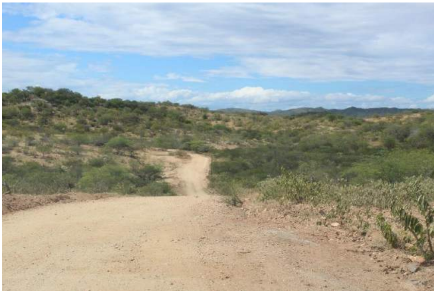
Figura 25 – Estrada de Acesso à Comunidade Rural Timbaúba, 2019
