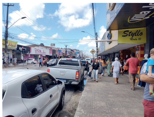
Figura 47: Ponto com esgoto exposto no contexto 2
