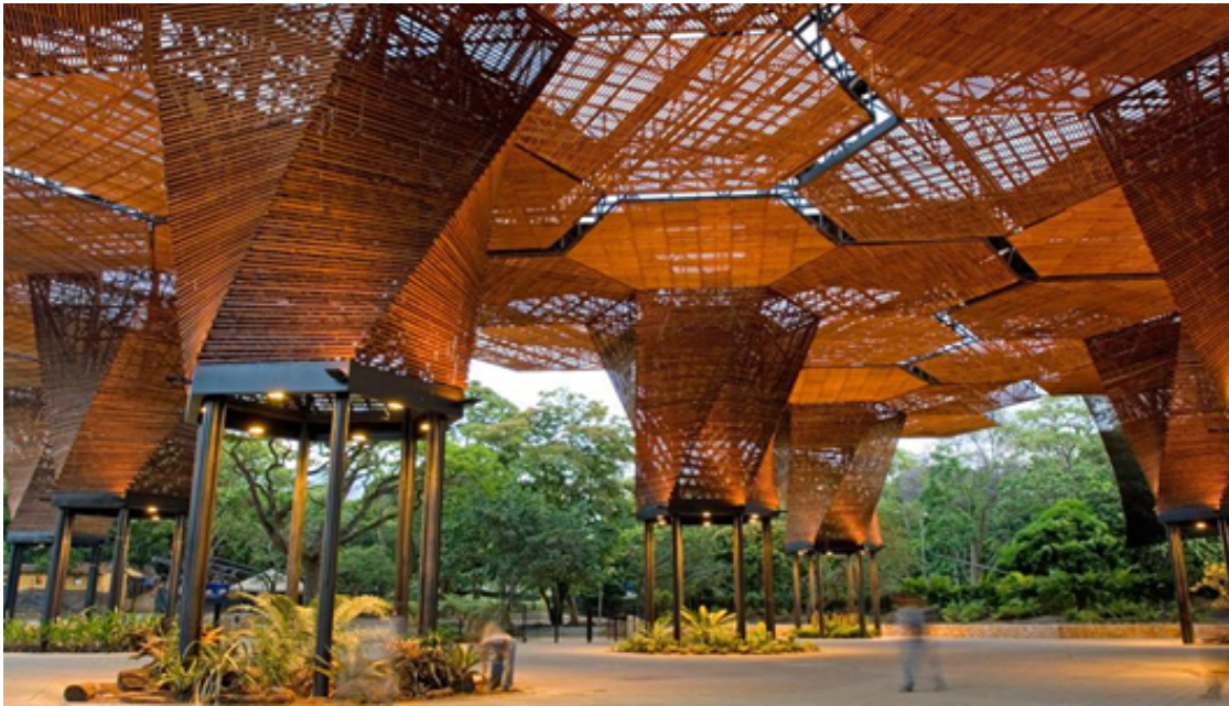
Figura 15: Estrutura do pátio interno e relação da coberta com o entorno.
