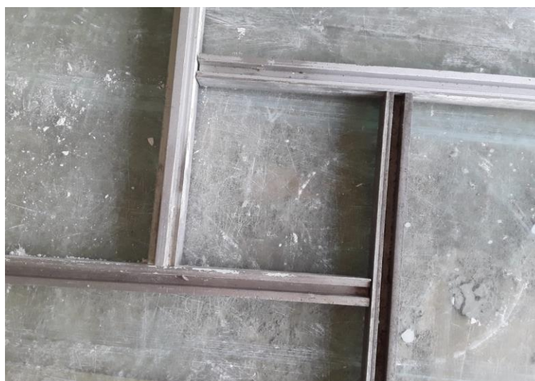
Figura 9 - Montagem do molde para confecção das placas
