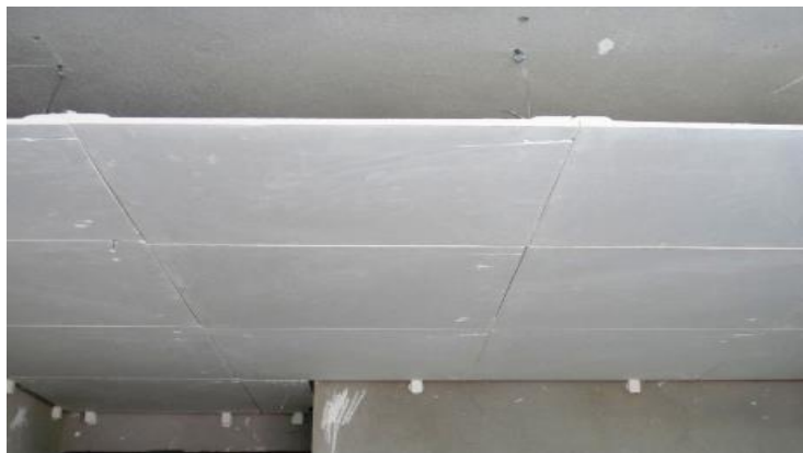
Figura 1 - Montagem de forro residencial
