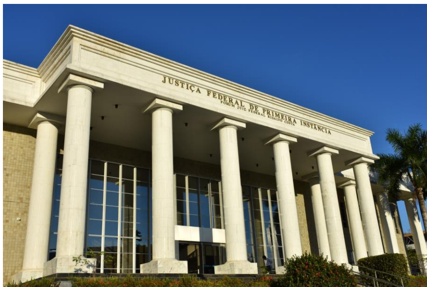
FIGURA 01: Prédio da Justiça Federal da Paraíba
