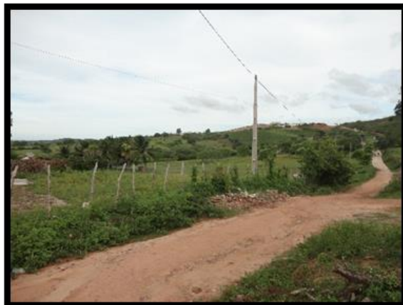
Figura 7: Estrada sentido comunidade cidade de Dona Inês/PB.
