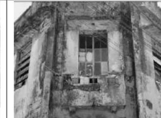
**Imagem 11:** Fachada frontal principal do edifício Leste da antiga IVS. Destaca-se a varanda do primeiro pavimento em arruinamento.
