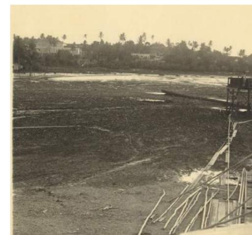
Figura 05 - Aterro do capinzal com lama dragada pela Parahyba, 1922.
