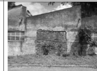
**Imagem 16:** Fachada frontal do edifício Nordeste da antiga IVS, rua Professora Analice Caldas. Destaca-se a abertura que sugere uma antiga porta, vedada com tijolos 8 furos.
