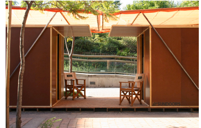
Figura 16: Varanda de conexão entre ambientes.
