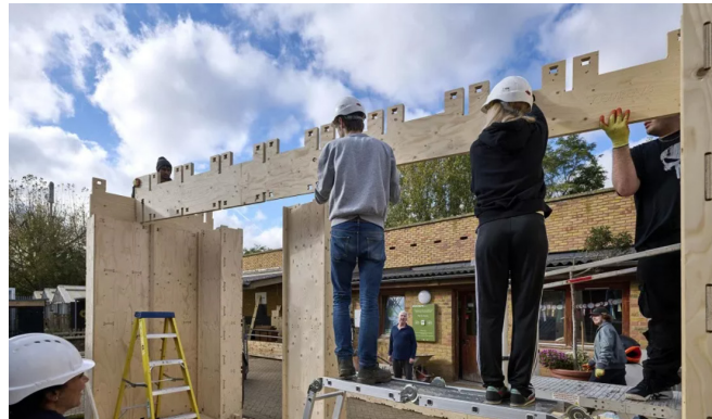
Figura 17: Processo de montagem da WikiHouse
