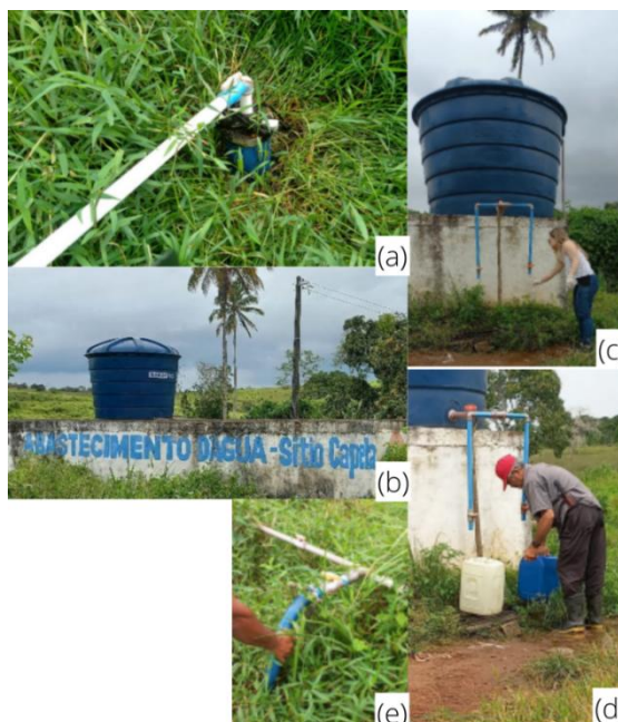
Figura 45 - Ponto de coleta. (a) Poço da Capela (C9); (b) e (c) Reservatório; (d) Morador coletando água; (e) Mangote.
