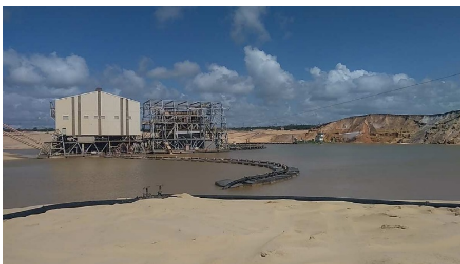
Figura 7 - Planta Flutuante de Concentração da Mina Guajú
