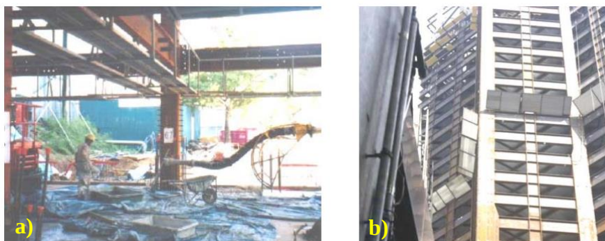
Figura 2.35 - Emprego dos pilares mistos preenchidos em Hong Kong – Quens Central Tower : a) preenchimento do pilar; b) exemplo de utilização em edifícios
