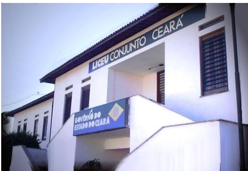
Figura 6: Fachada Escola LICEU do Conjunto Ceará.
