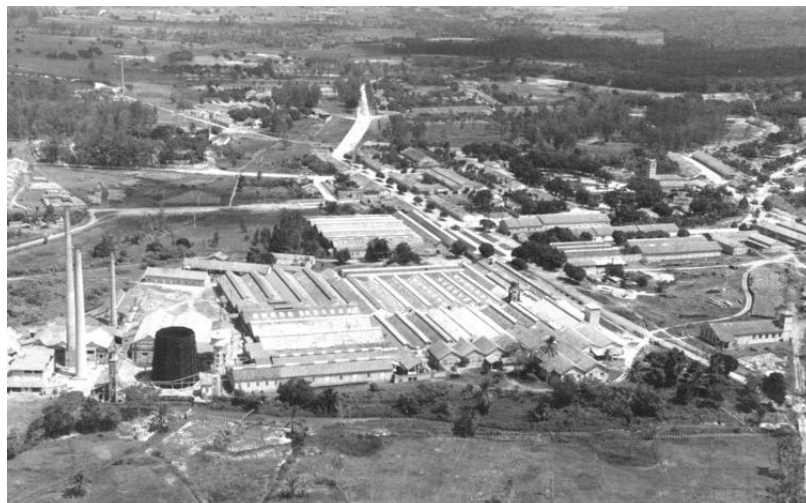
Figura 6 – Vista aérea da fábrica de Rio Tinto.
