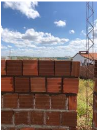
Figura 2: Empilhamento dos tijolos
