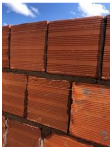
Figura 3: Muro com amarração
