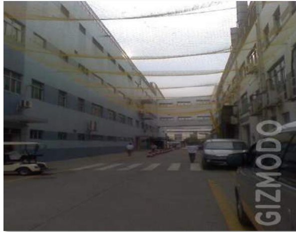
Figura 2 – Telas de proteção na Foxconn
