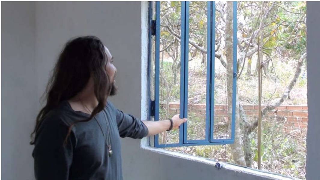
Foto 2: Saga mostrando uma janela velha que foi reformada e adaptada para abrir para fora. FONTE: Arquivo pessoal (2019)
