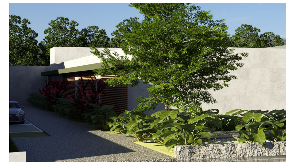
FIGURA 86: IMAGEM ILUSTRANDO A FACHADA OESTE MARCADA POR ELEMENTOS COMO MARQUISES, BRISSES VERTICAIS E VEGETAÇÃO. / FONTE : ELABORADO PELA AUTORA
