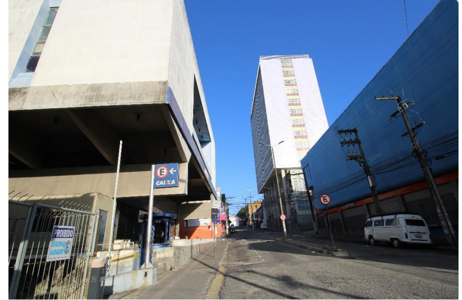
Figura 29 – Edifício do INSS sem o destaque devido. (Fonte: Autoria própria)
