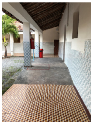
Figura 27 e 28: 1- Desnível no acesso a área de convivência 2- Desnível na circulação:
