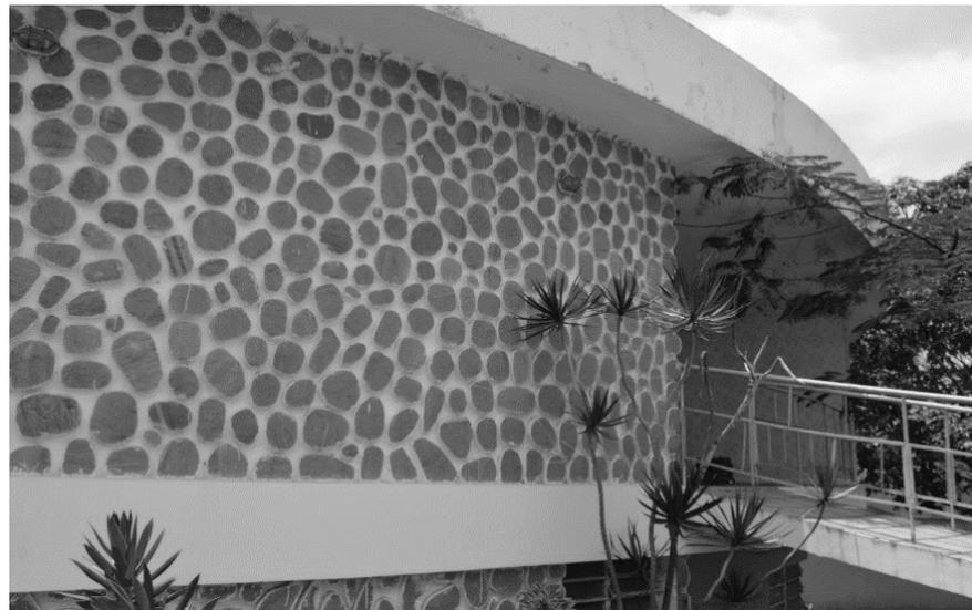
Os elementos de vedação são predominantemente fechados e opacos em relação ao aberto e transparente, devido principalmente, os fechamentos em alvenaria, com ou sem revestimento. Apesar da quantidade reduzida de aberturas, os da fachada curva são bem delimitadas de piso a teto, graças as vigas invertidas da estrutura de cobertura, apontando para um modo de construir moderno, ressaltando assim, alguns dos fechamentos [Figura 120].
