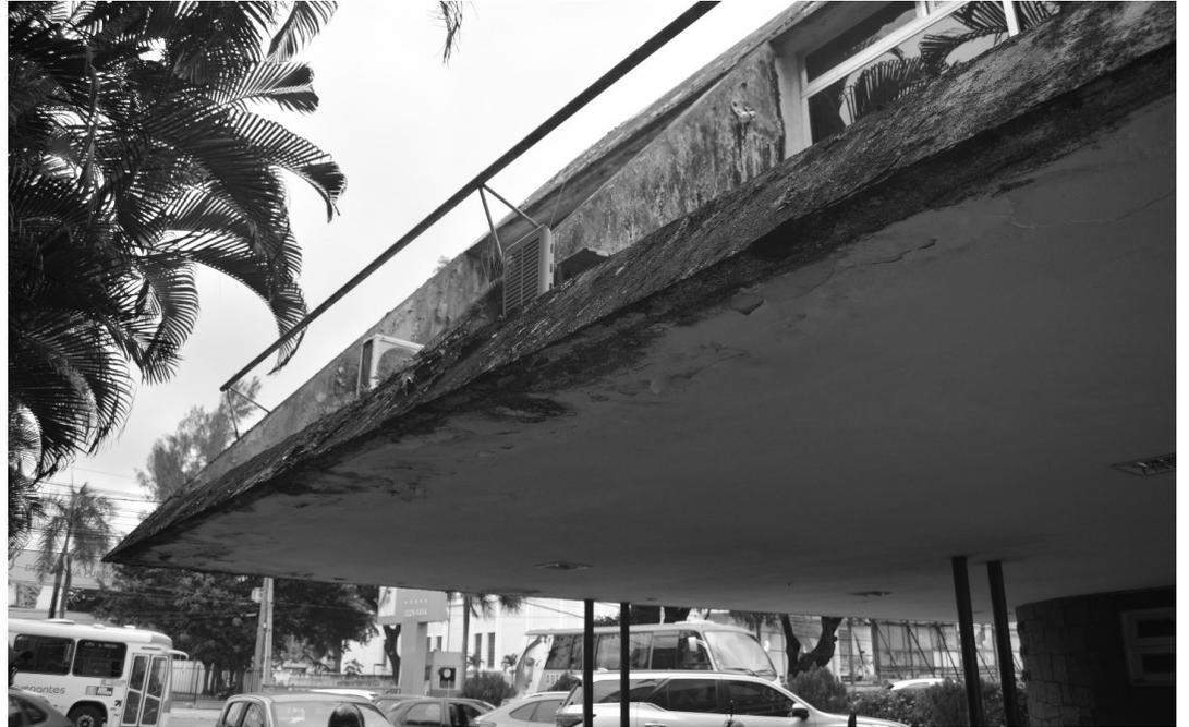
trabalha com um único perfil metálico de seção circular que é apoiado nas empenas inclinadas das varandas por outro perfil de seção circular menor, dobrado em forma de “v” [Figura 82] – um contraste evidente com o guarda corpo da escada interna. .
