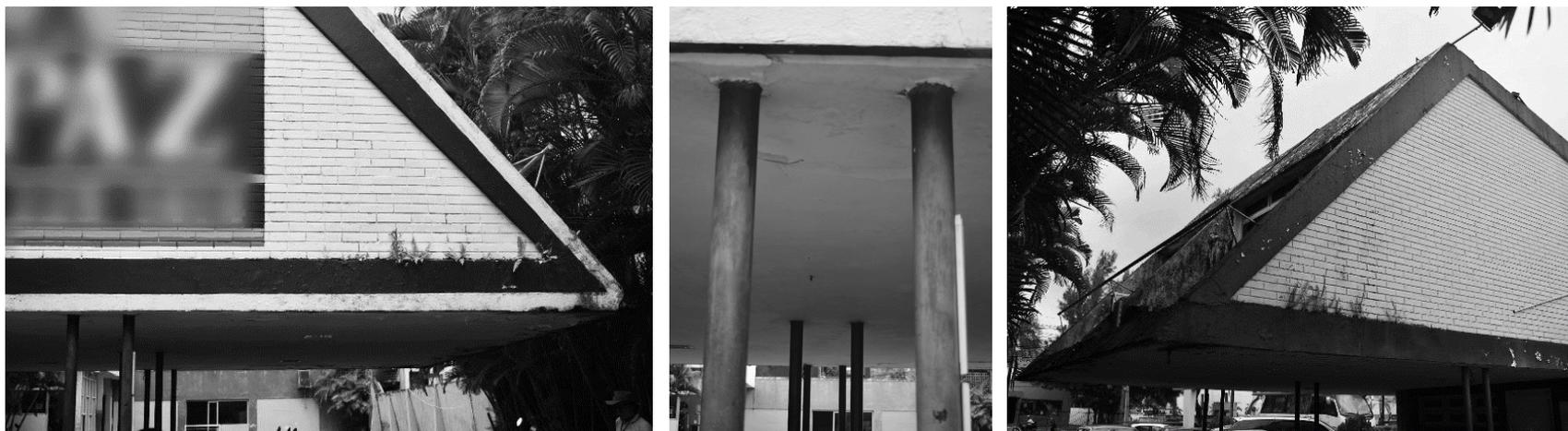
**Figura 72** Detalhe dos pilares em aço que sustentam parte das cargas do pavimento superior.
