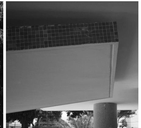
inclinada em duas direções, sendo três metros para o lado oeste, engastada na viga superior por uma espécie de “mão francesa” de concreto [Figura 40]. Outro detalhe construtivo que é possível identificar, que revela um cuidado construtivo, é o uso de um delicado friso (pingadeira) contornando todas as lajes [Figura 41].
