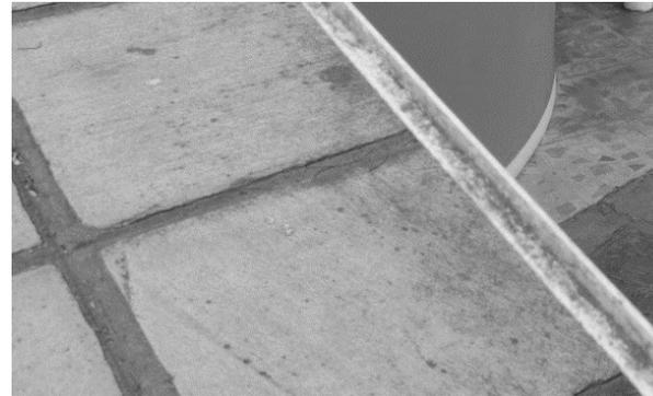
**Figura 118** Detalhe do revestimento em pedra da rampa e do piso do jardim.
