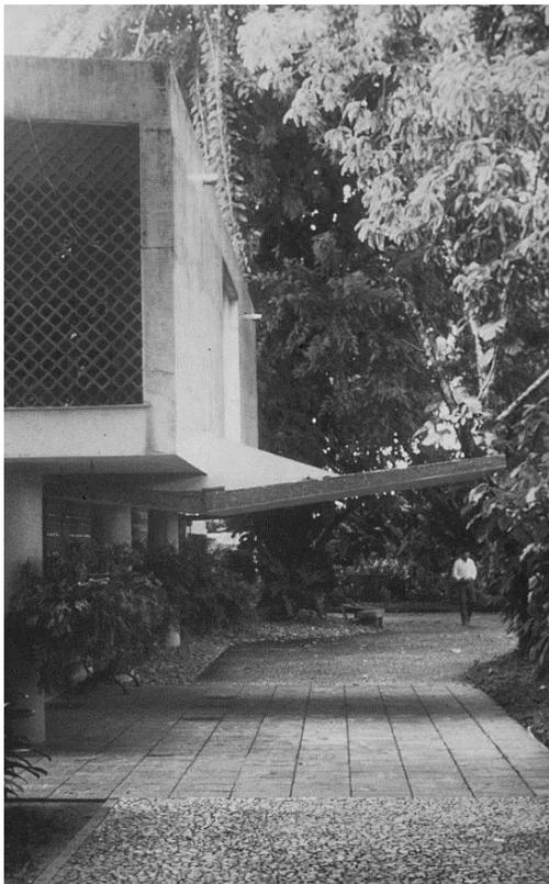
**Figura 41** Detalhe da marquise em balanço com pingadeira na laje.
