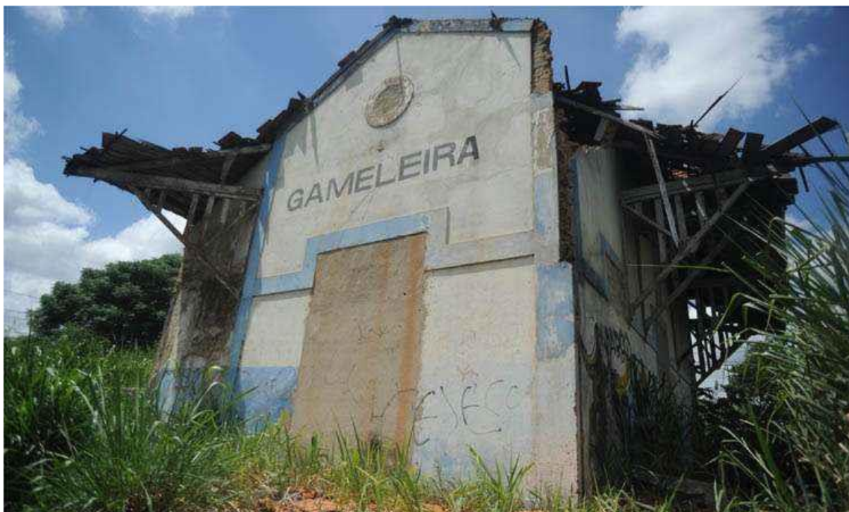
Figura 2864 - Estação Ferroviária da Gameleira, MG deteriorada.
