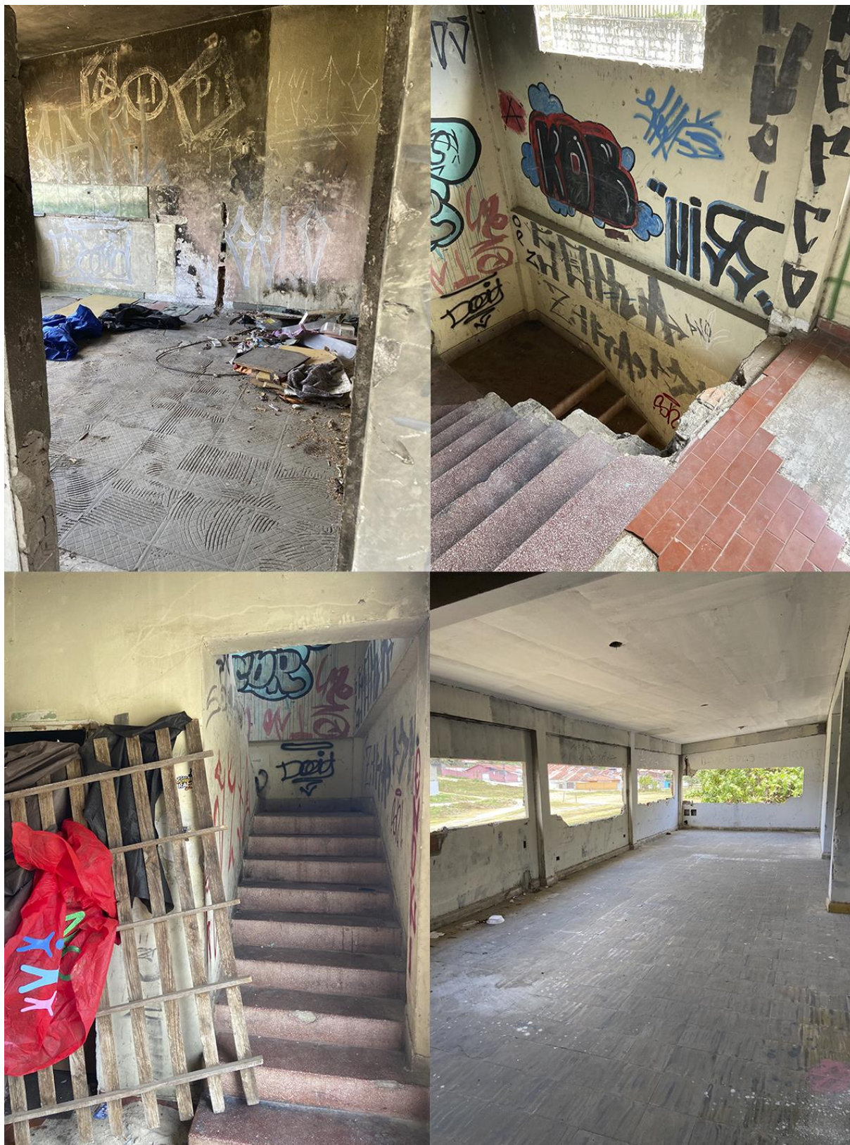
Figura 45 - Colagem de fotos do interior do Escritório Técnico.
