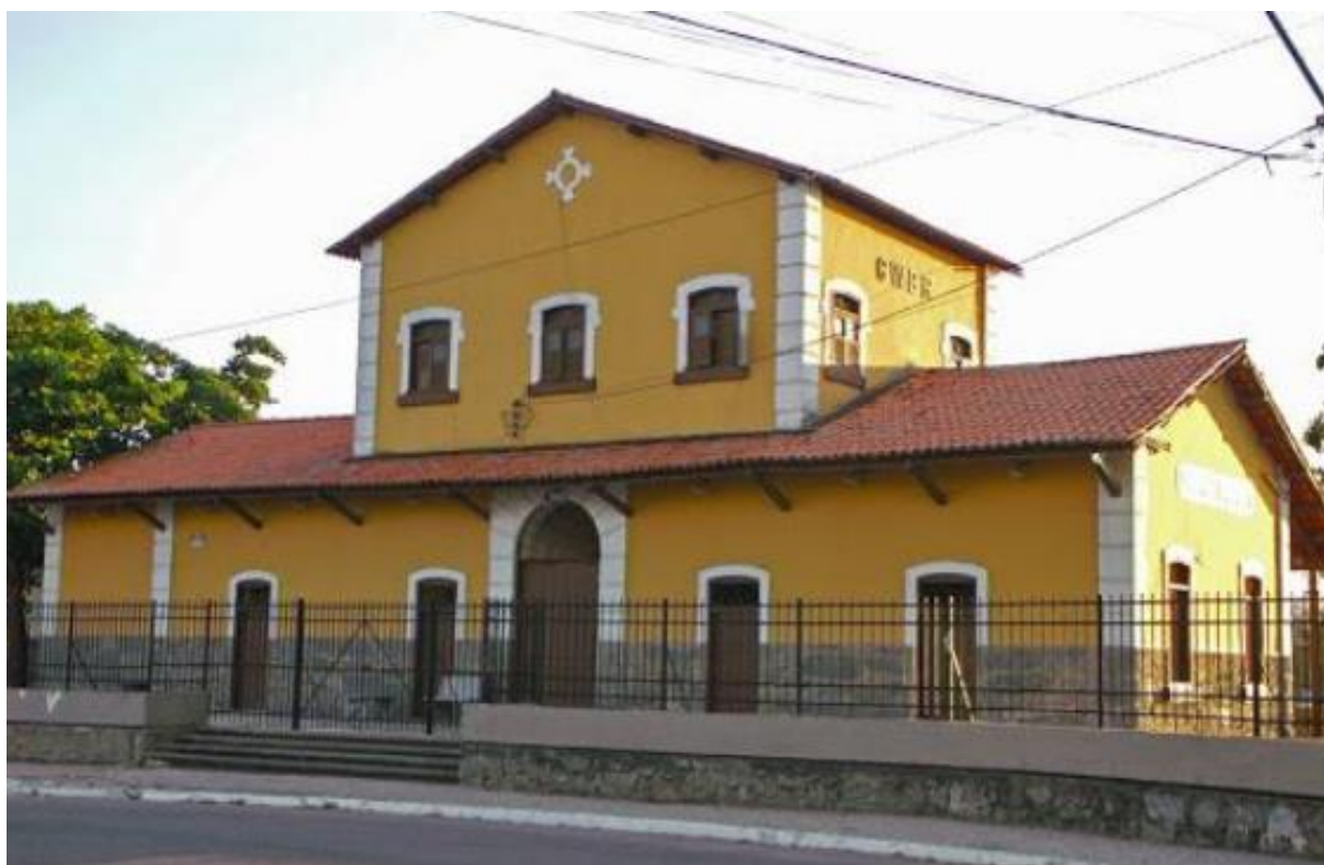
Figura 2507 - Fachada principal da Estação Velha de Campina Grande-PB.
