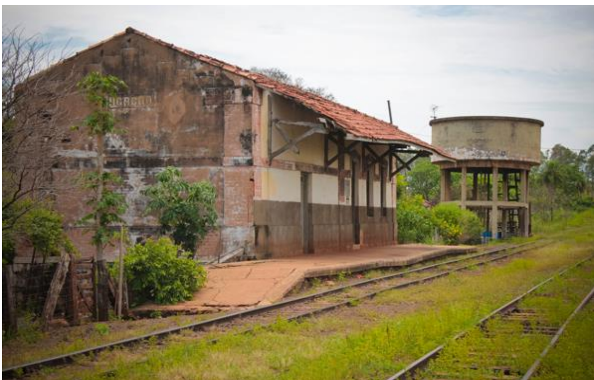
Figura 103277 - Estação de Ligação, Mato Grosso abandonada.
