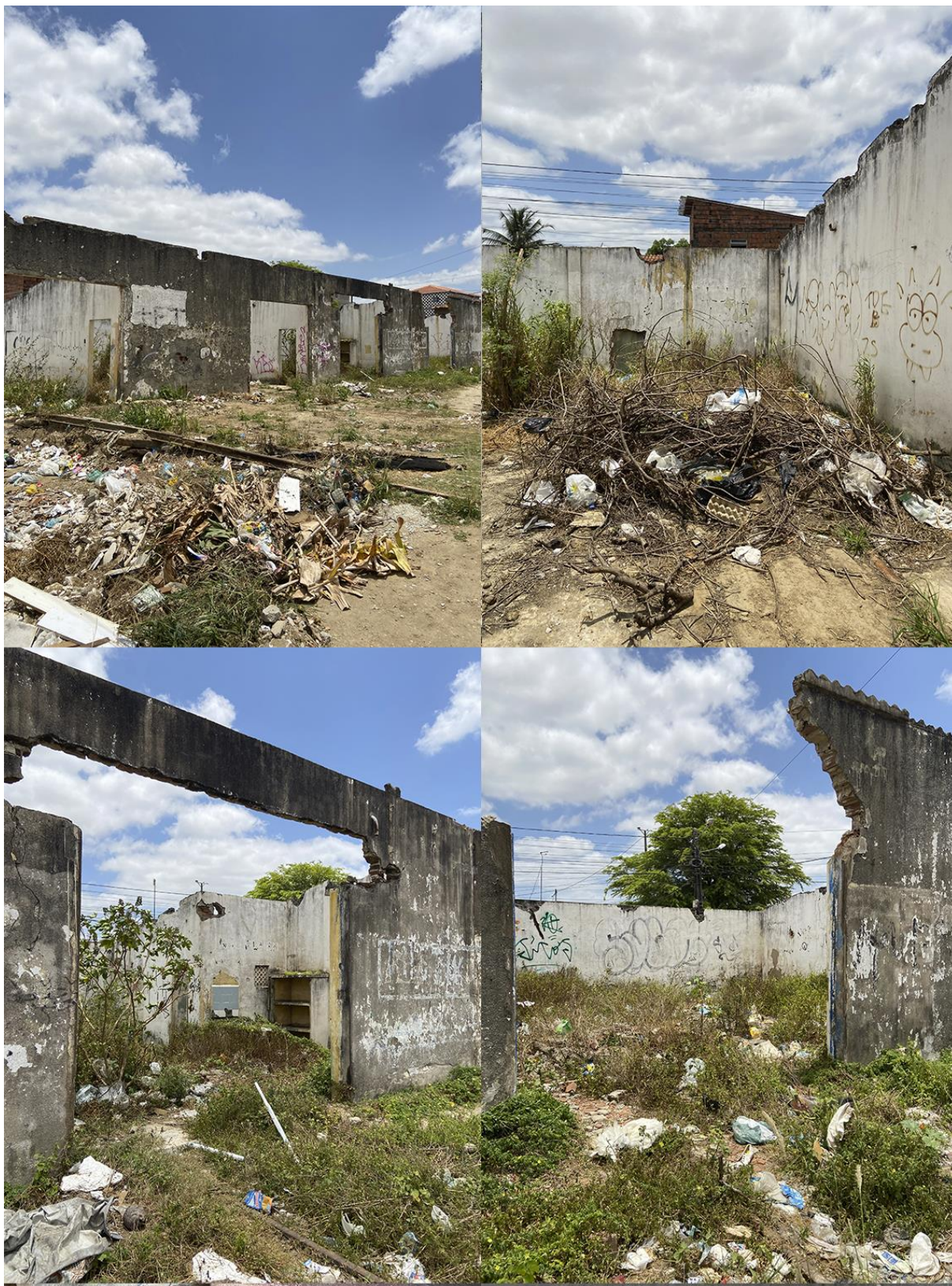
Figura 55 - Colagem de fotos do interior e entorno da Oficina de manutenção.
