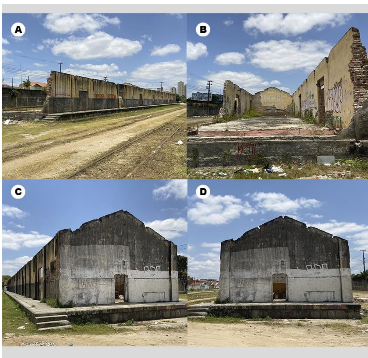
Figura 41 - Imagens da leitura do lugar: Galpão de armazenamento.
