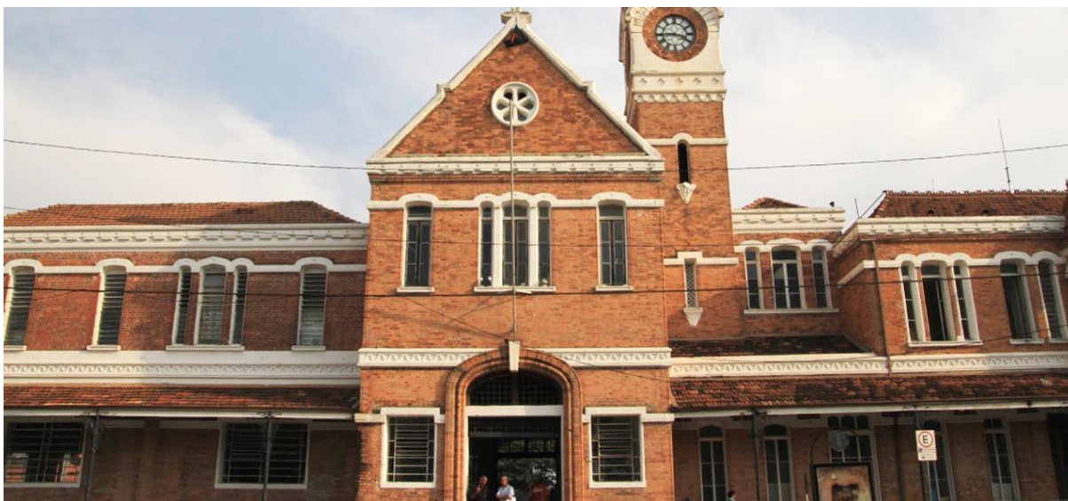
Figura 101 - Fachada da Estação Ferroviária de Campinas.
