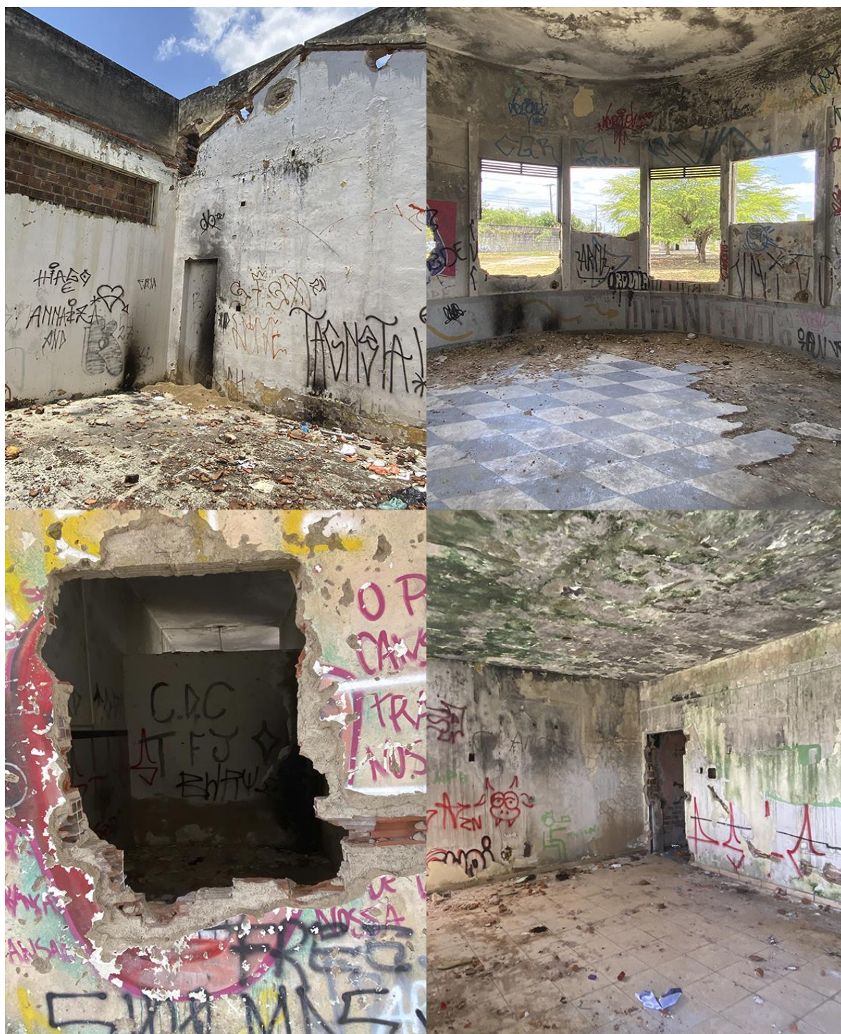
Figura 49 - Colagem de fotos do interior da Estação Nova.
