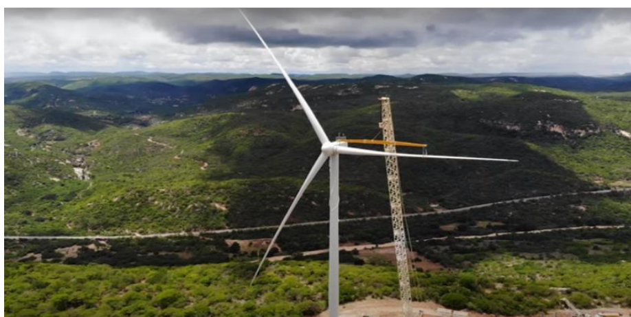
Figura 3 - Parque Eólico Chafariz, em Santa Luzia, PB
