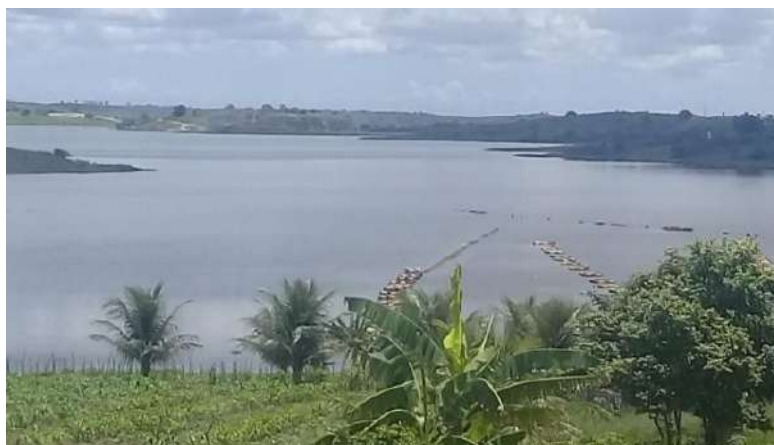
Figura 1 - Vista geral da barragem de Araçagi
