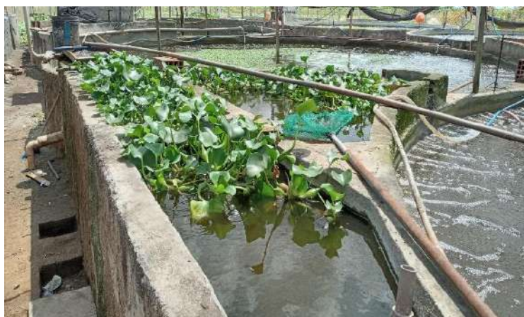
Figura 32. Detalhe do sistema de filtragem da água com o uso de plantas aquáticas, que complementa o tratamento da água com o uso de tanques de decantação.
