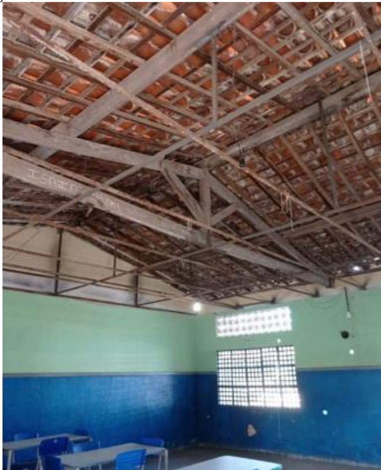
Imagem 61 - Estrutura do teto de uma das salas da Escola Estadual Belém Câmara
