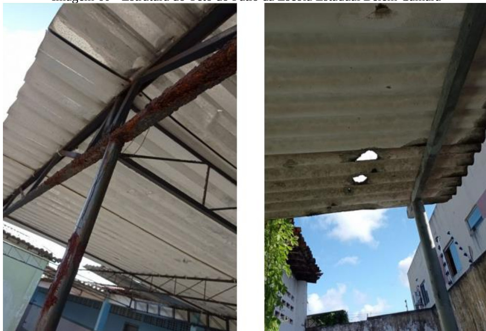
Imagem 60 - Estrutura do Teto do Pátio da Escola Estadual Belém Câmara
