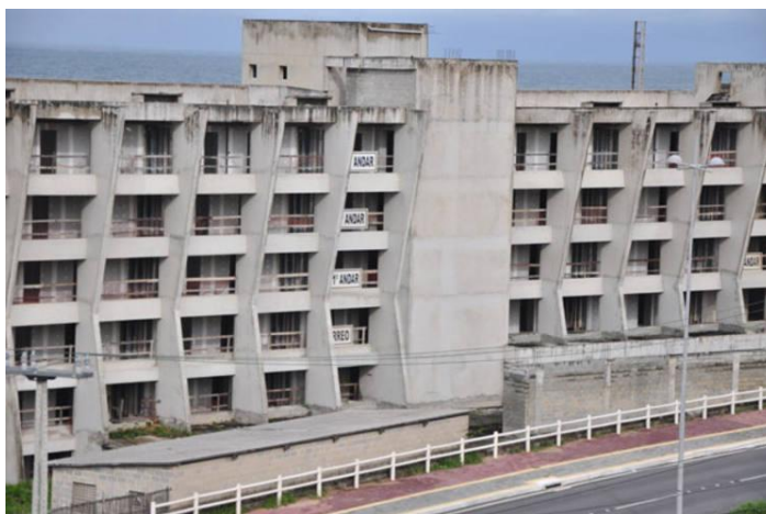
Figura 1 – Fotografia da parte traseira da obra do Hotel da construtora NATHWF, mostrando os pavimentos que passam da avenida (existem pavimentos abaixo do nível do meio-fio) oferecendo um paredão de bloqueio para quem nela se posiciona. (Fonte: www.sospontanegra.org , 2011)
