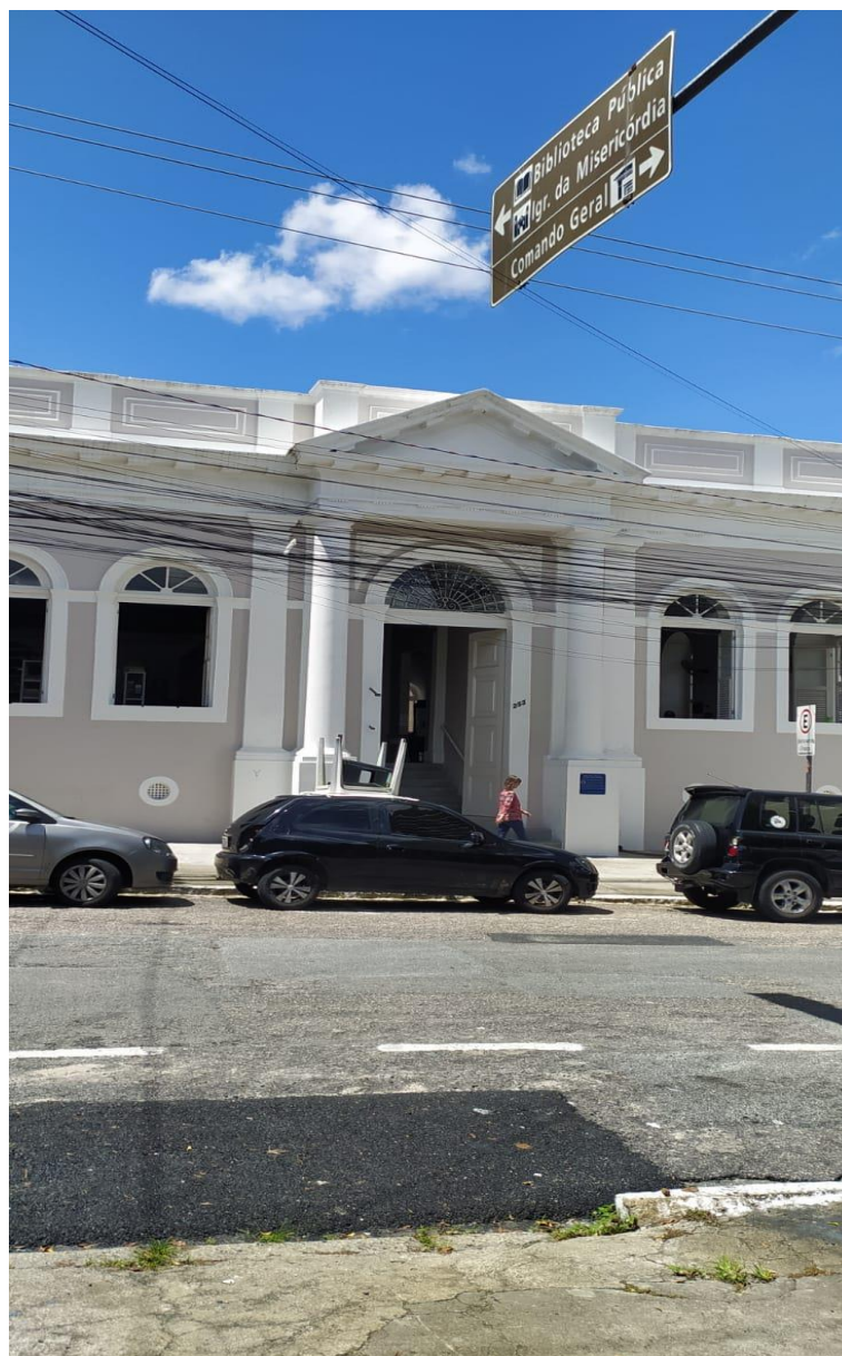
Figura 7 - Ambiente externo da Biblioteca Pública Augusto dos Anjos
