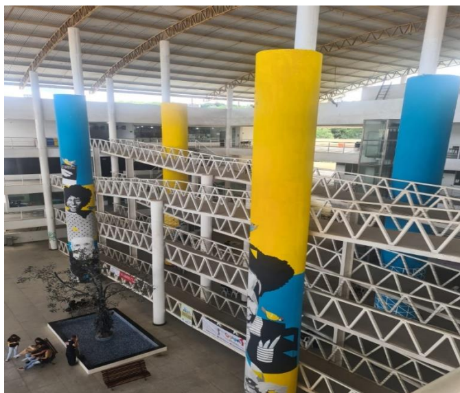
Figura 5: Rampa de acessibilidade da Central de Aulas Paulo Freire – UEPB Campina Grande
