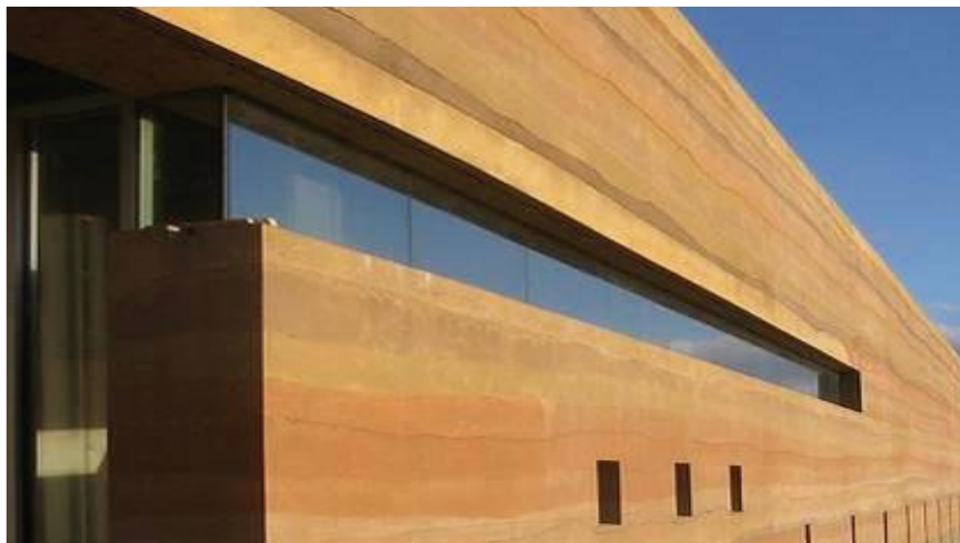
Figura 5 – Edificação de terra feita com taipa de pilão.
