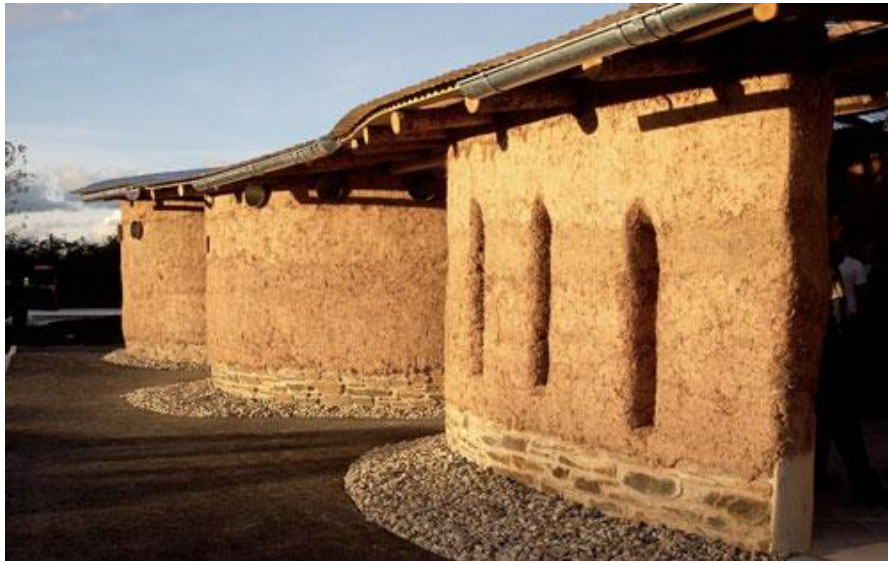
Figura 4 – Edificação em cob.
