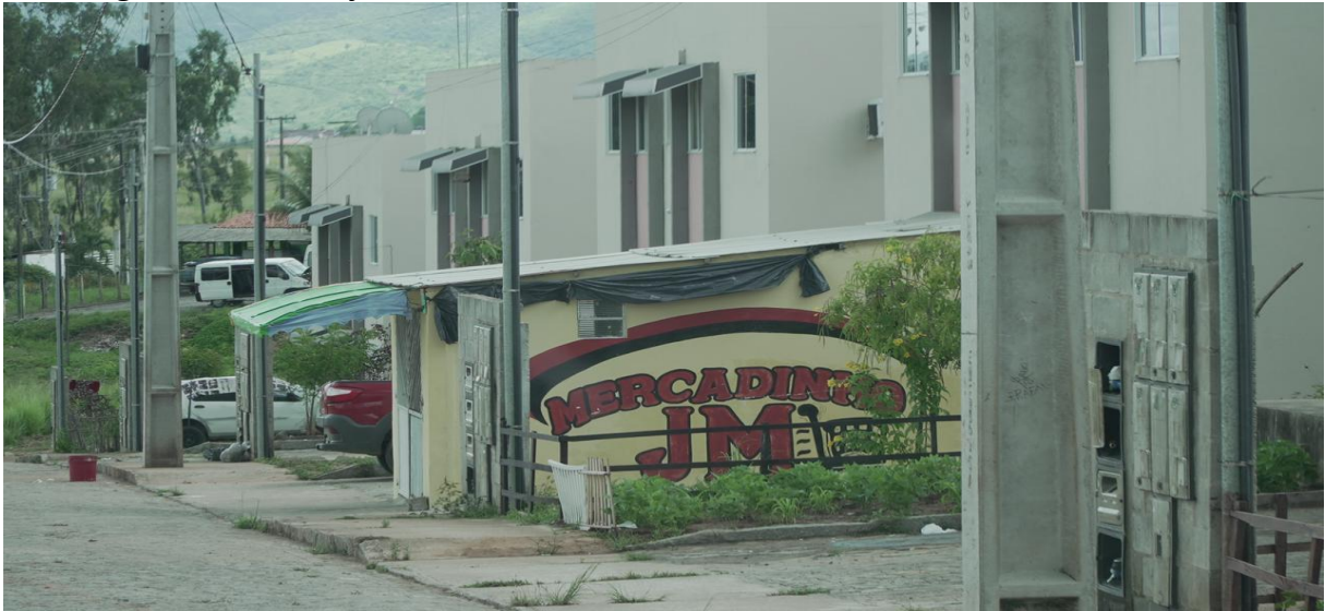
Figura 9 - Construção de comércio em área comum
