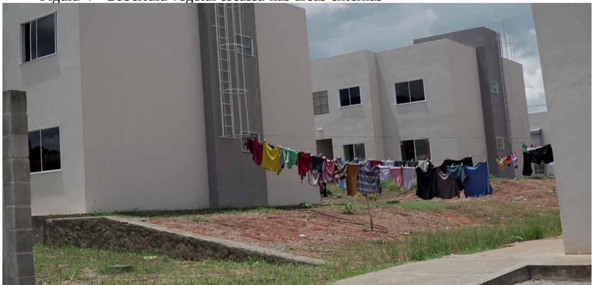
Figura 4 - Cobertura vegetal escassa nas áreas externas
