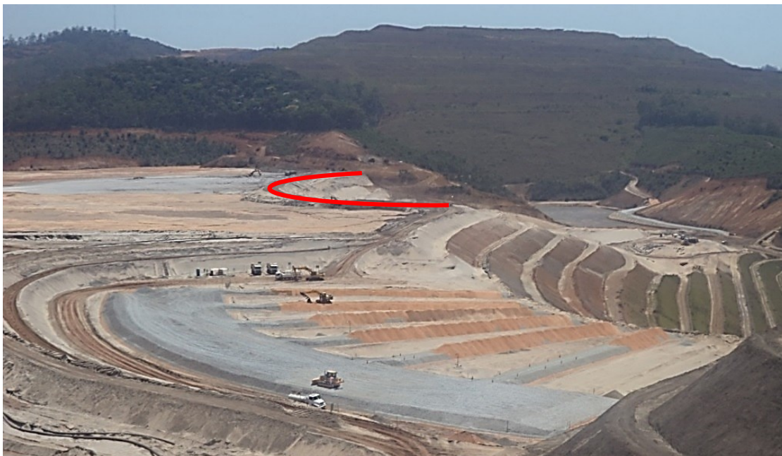
Figura 18 - Imagem em primeiro plano da construção do tapete drenante da OD, e ao fundo, em destaque, a geometria curva do eixo recuado em direção da OE. Fonte: SAMARCO (2015) apud MPF (2016).
