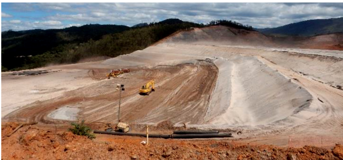
Figura 17 - Imagem da construção da berma de equilíbrio no eixo recuado, iniciada em 28/08/2014. Fonte: SAMARCO (2014) apud MPF (2016).
