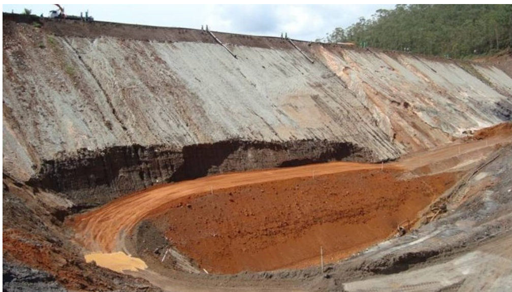
Figura 11 - Imagem da conclusão da construção do septo de argila nos drenos de fundo, a montante do Dique 1. Fonte: SAMARCO (2009) apud MPF (2016).
