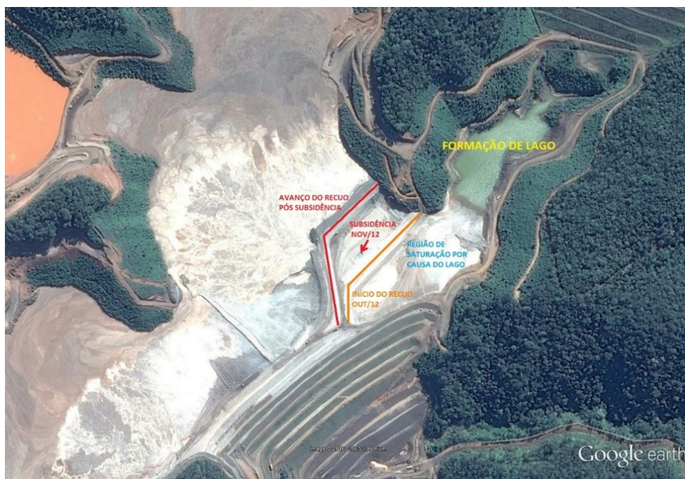
Figura 15 - Vista geral do Dique 1 em maio/2013, onde se observa o início do recuo do eixo de out/12, a subsidência de 25nov12 e avanço do recuo do eixo pós subsidência, bem como a formação de lago na grota da VALE e sua proximidade, influenciando na saturação do reservatório do Fundão. 17
