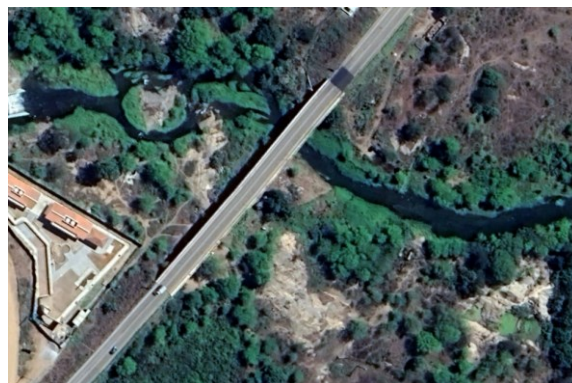
Figura 05 – Ponte localizada no município de Monteiro, PB
