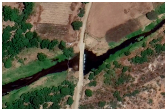
Figura 04 – Passagem molhada localizada no município do Congo, PB
