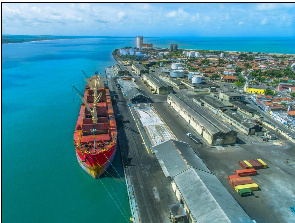
Figura 5: Vista do porto de Cabedelo/PB.
