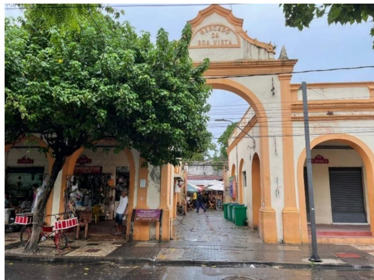
Figura 6 - Fachada do Mercado da Boa Vista
