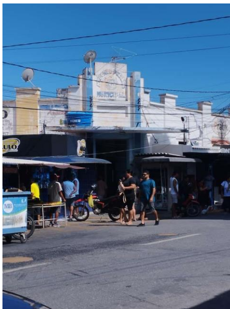
Figura 9 - Fachada do Mercado Municipal de Patos
