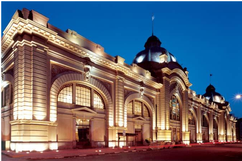
Figura 3 - Fachada do Mercado Municipal de São Paulo
