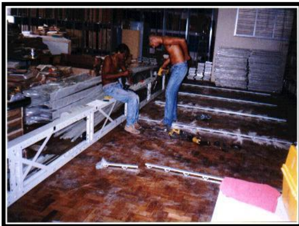
Imagem 7 – Reforma da Biblioteca
