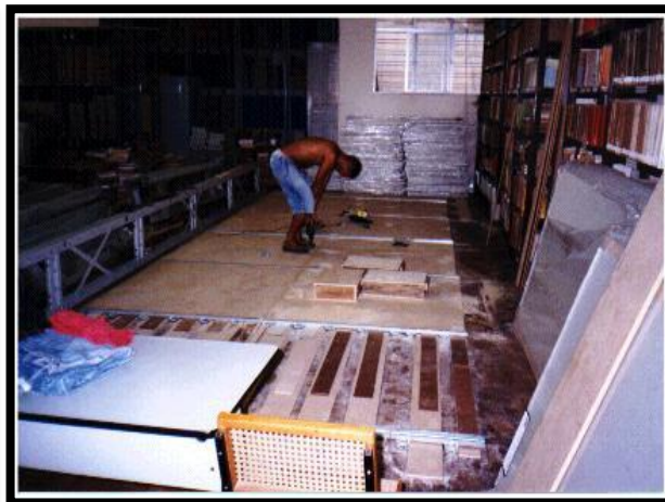
Imagem 8 – Reforma da Biblioteca
