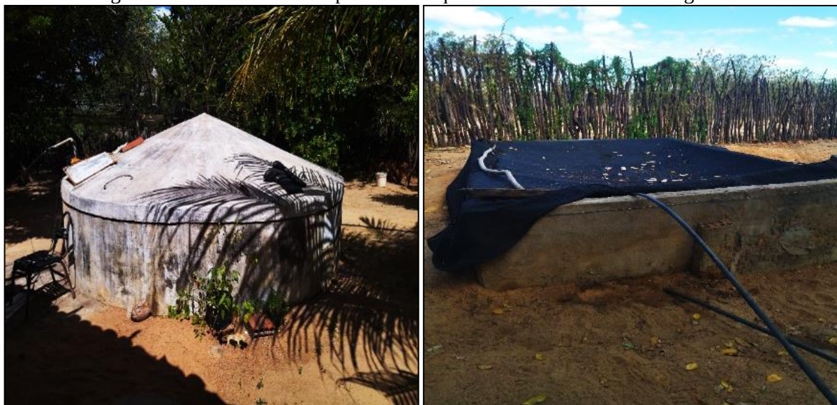
Figuras 39 e 40- Cisterna de placas e Tanque de concreto no PA Mulunguzinho.
