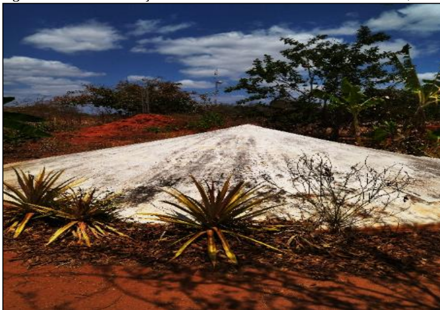
Figura 41 - Cisterna Calçadão no PA Professor Maurício de Oliveira, 2021.
