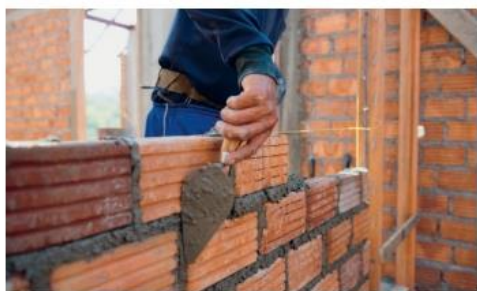
Tijolo cerâmico sendo utilizado na construção de um muro.
