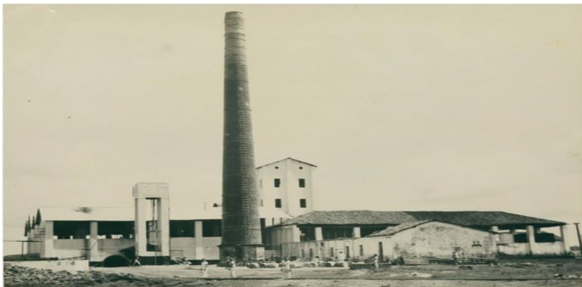
Foto 2 – Usina Santa Rita em Santa Rita-PB
