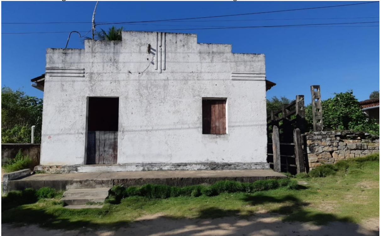
Figura 4 - Casa de alvenaria dos moradores mais antigos da Fazenda Santa Lúcia
