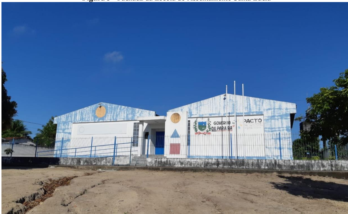
Figura 9 - Fachada da Escola do Assentamento Santa Lúcia
