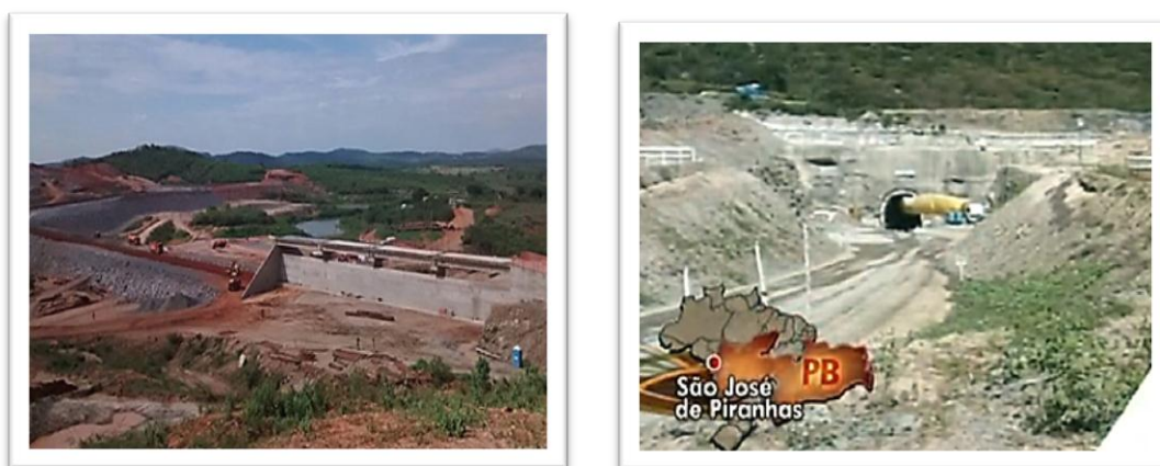
FIGURA14 BARRAGEM BOA VISTA (ESQUERDA) E TÚNEL CUNCAS EM CONSTRUÇÃO I (DIREITA)
