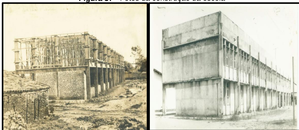
Figura 37 - Fotos da construção da escola
