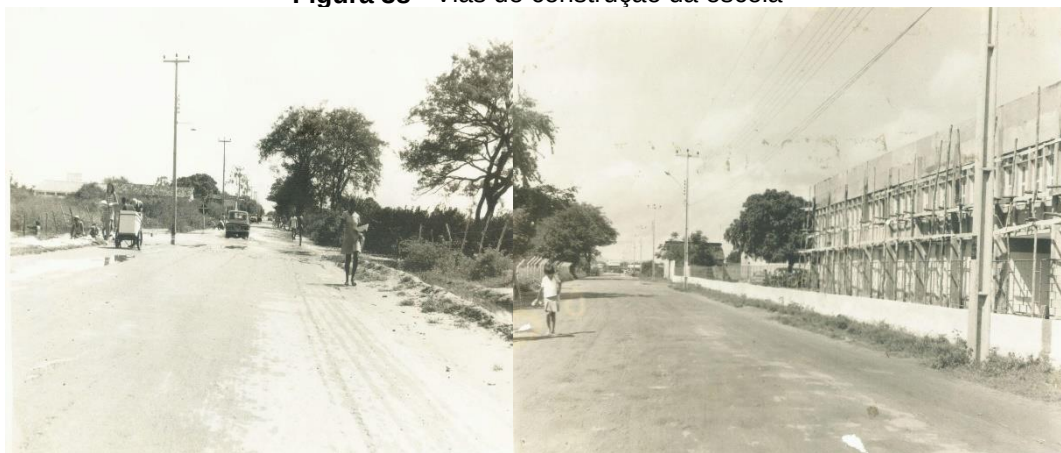
Figura 38 - Vias de construção da escola
